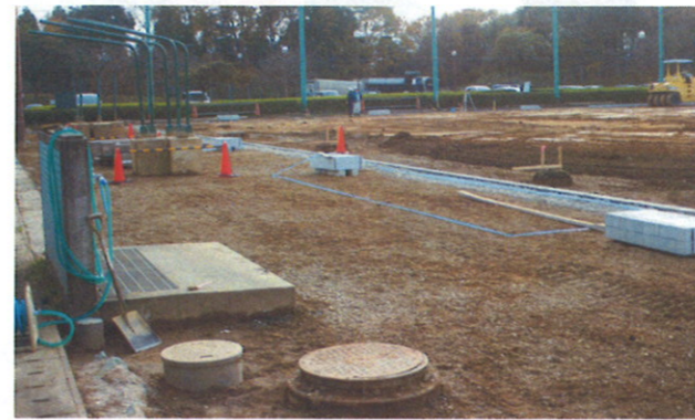
人工芝工事中 折笠スポーツ広場
